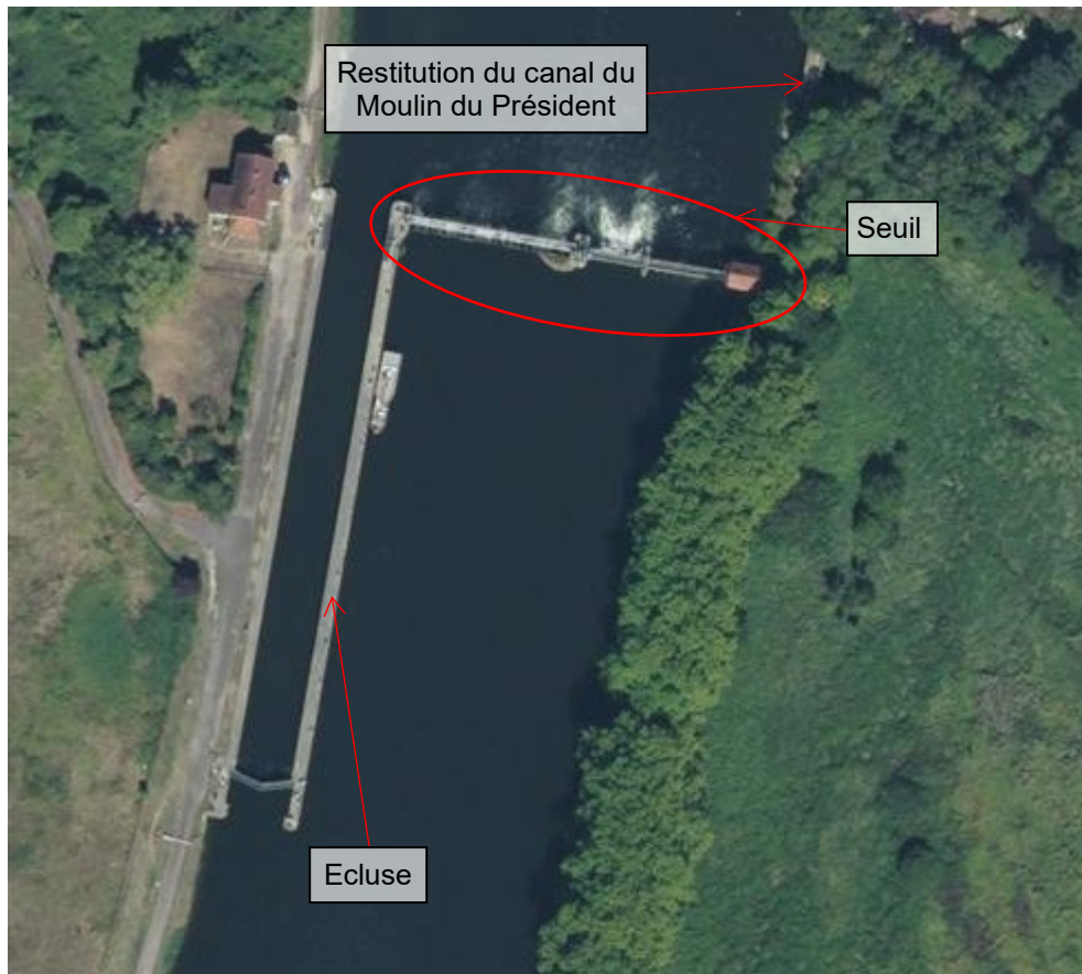
Figure 2 : Vue aérienne du barrage de l'Ile Brulée (source : Géoportail)
